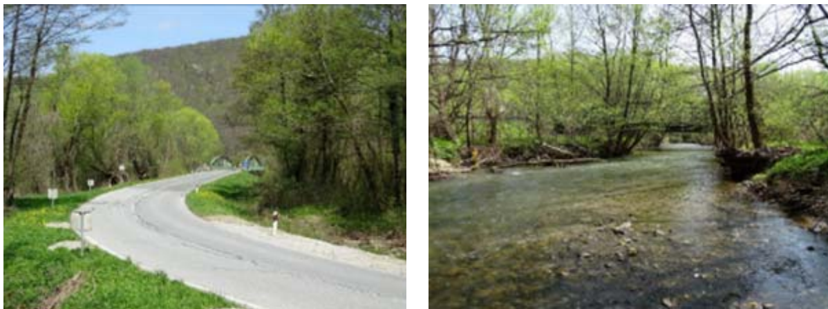
Slika 30. Početak zahvata kod mosta Orljavac (lijevo) i korito Orljave u blizini mosta (desno).
