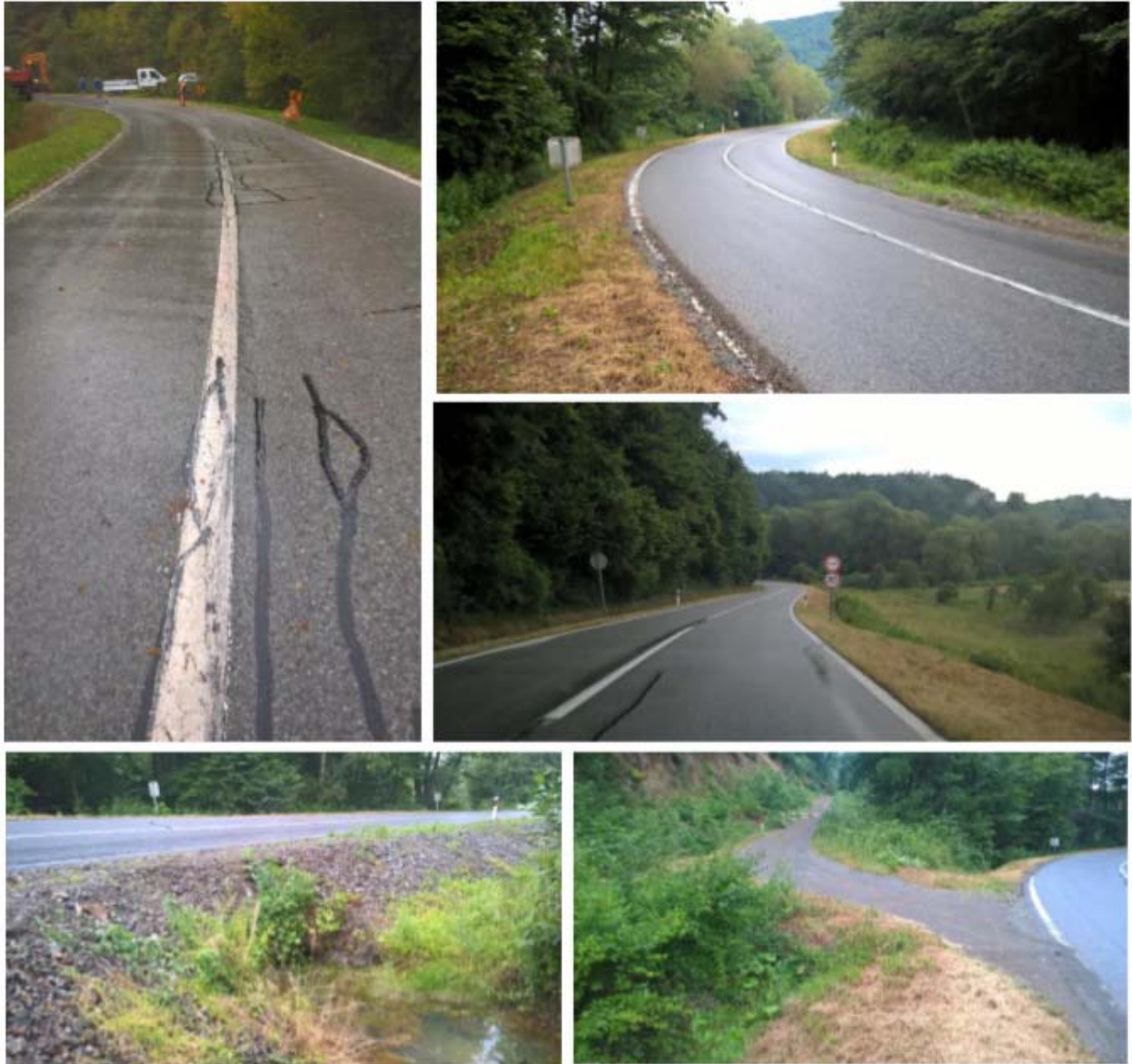
Slike 1.-5. Postojeće stanje promatrane dionice
